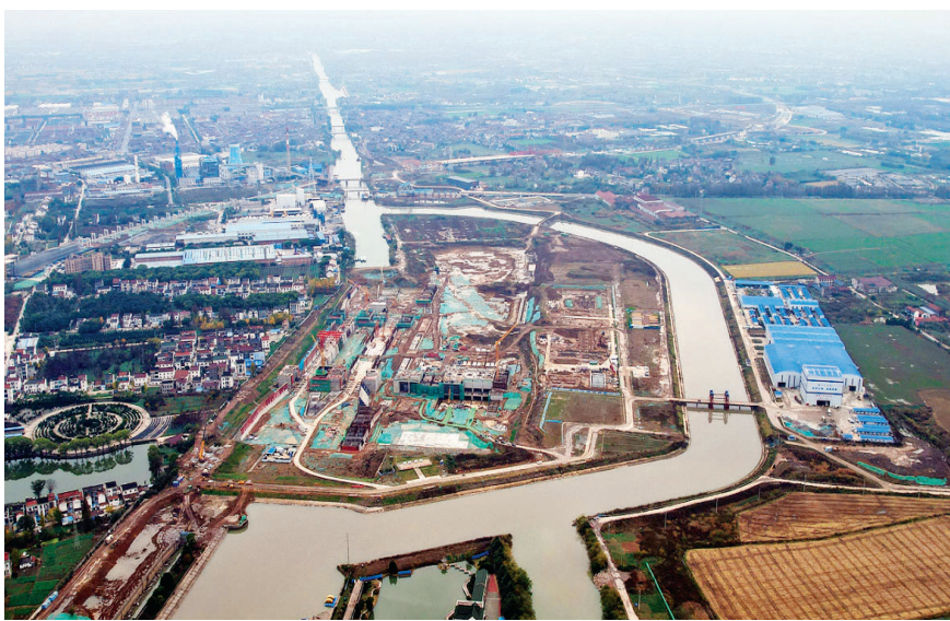
魏村枢纽扩容改建工程。王锐摄
