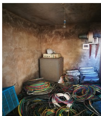
内胆车间贮源室现状
