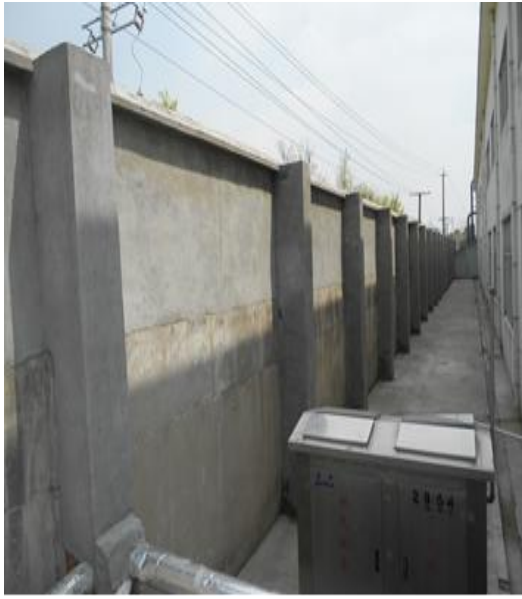
图 4-4-1 北侧围墙（治理前）
