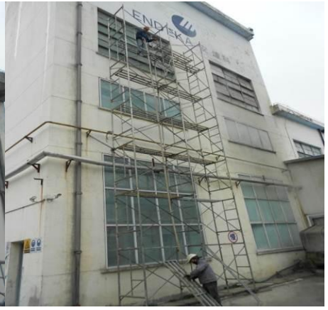
图 4-2-7 车间一炮楼玻璃窗（治理后）
