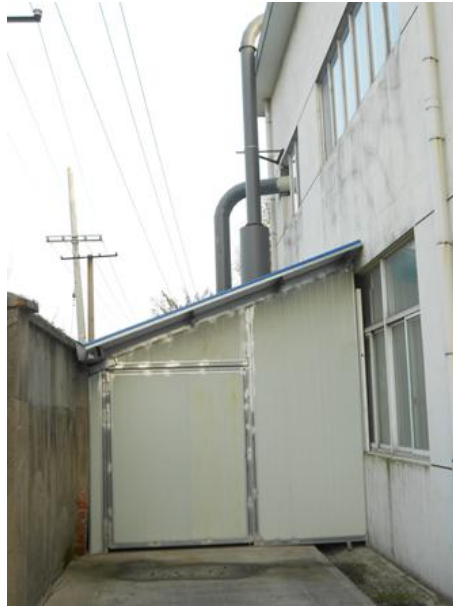
图 4-4-2 北侧围墙（治理后）
