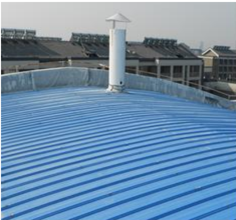
图 4-2-4 车间一炮楼屋顶（治理前）
