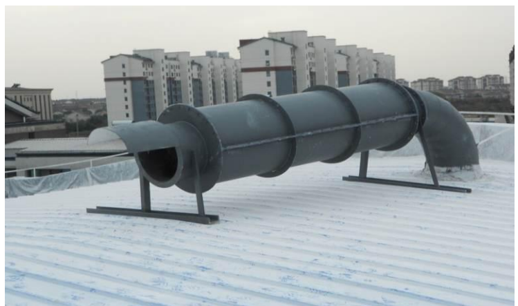
图 4-2-5 车间一炮楼屋顶（治理后）
