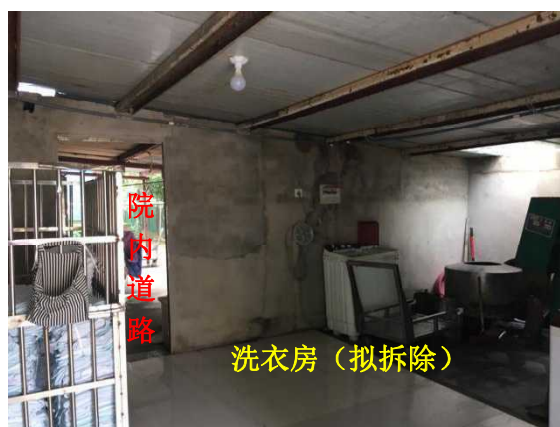
图 8-2 核医学科拟建址南侧洗衣房（拟拆除）
