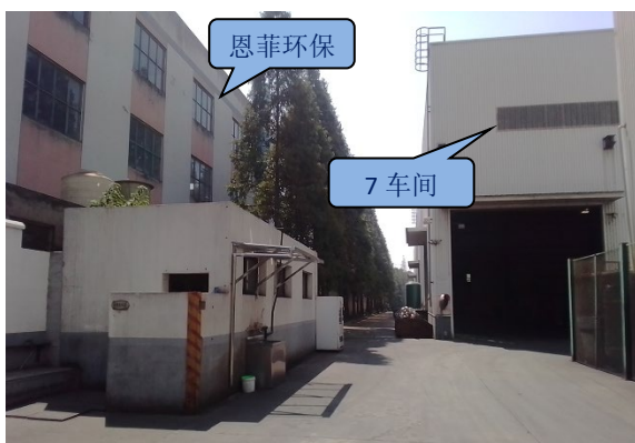
图 8-3 本项目拟建址东侧（7 车间外）
