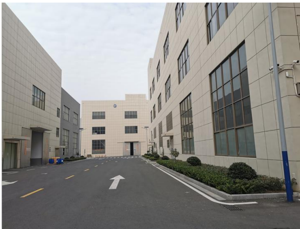
2#车间西侧厂区内道路
