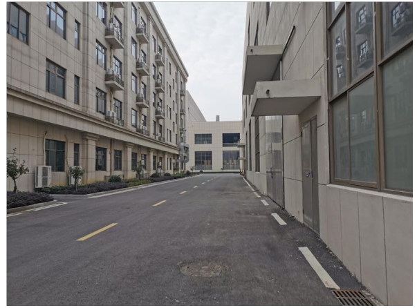
2#车间南侧厂区内道路
