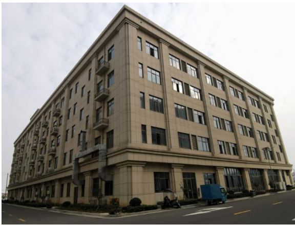
2#车间南侧办公楼
