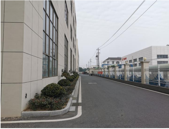
2#车间东侧厂区内道路
