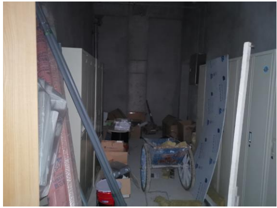
拟建 DSA 机房东侧控制室
