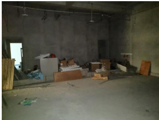
拟建 DSA 机房内部
