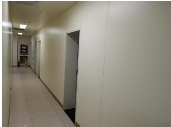
拟建 DSA 机房上方污物通道
