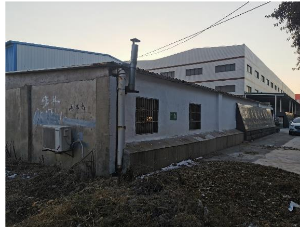
常州佳尔顺玻璃有限公司辅房
