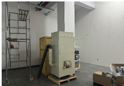
CT 实验室建址西侧（高压配电房）
