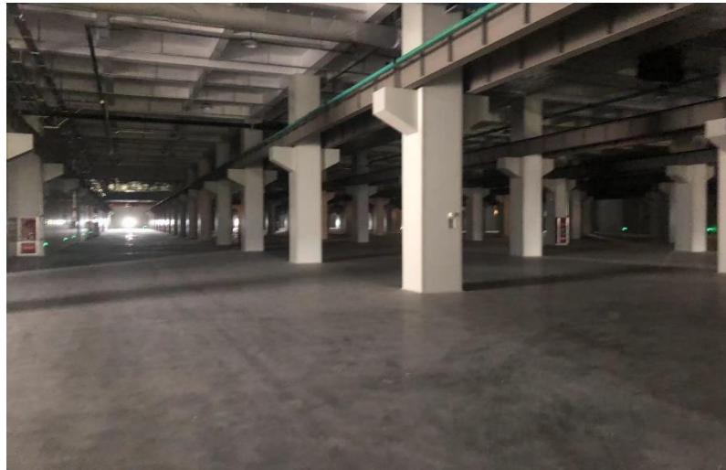
图 8-5 调试区上方（C栋生产厂房2层，厂房内空地）
