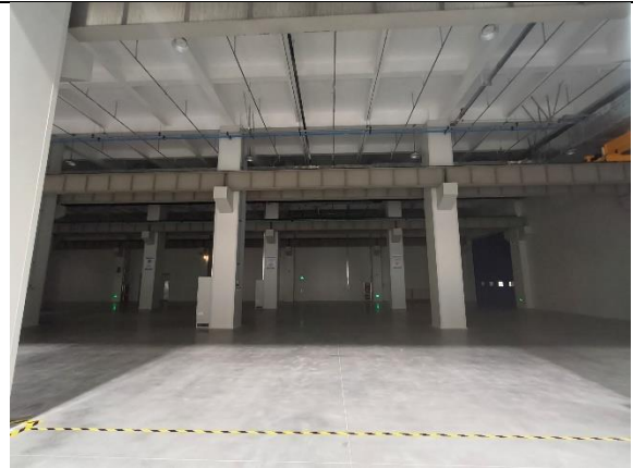
图 8-4 调试区北侧（厂房内空地）
