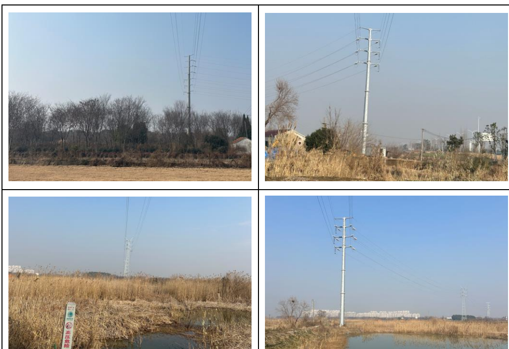
图 3-1 本项目周围环境现状照片
